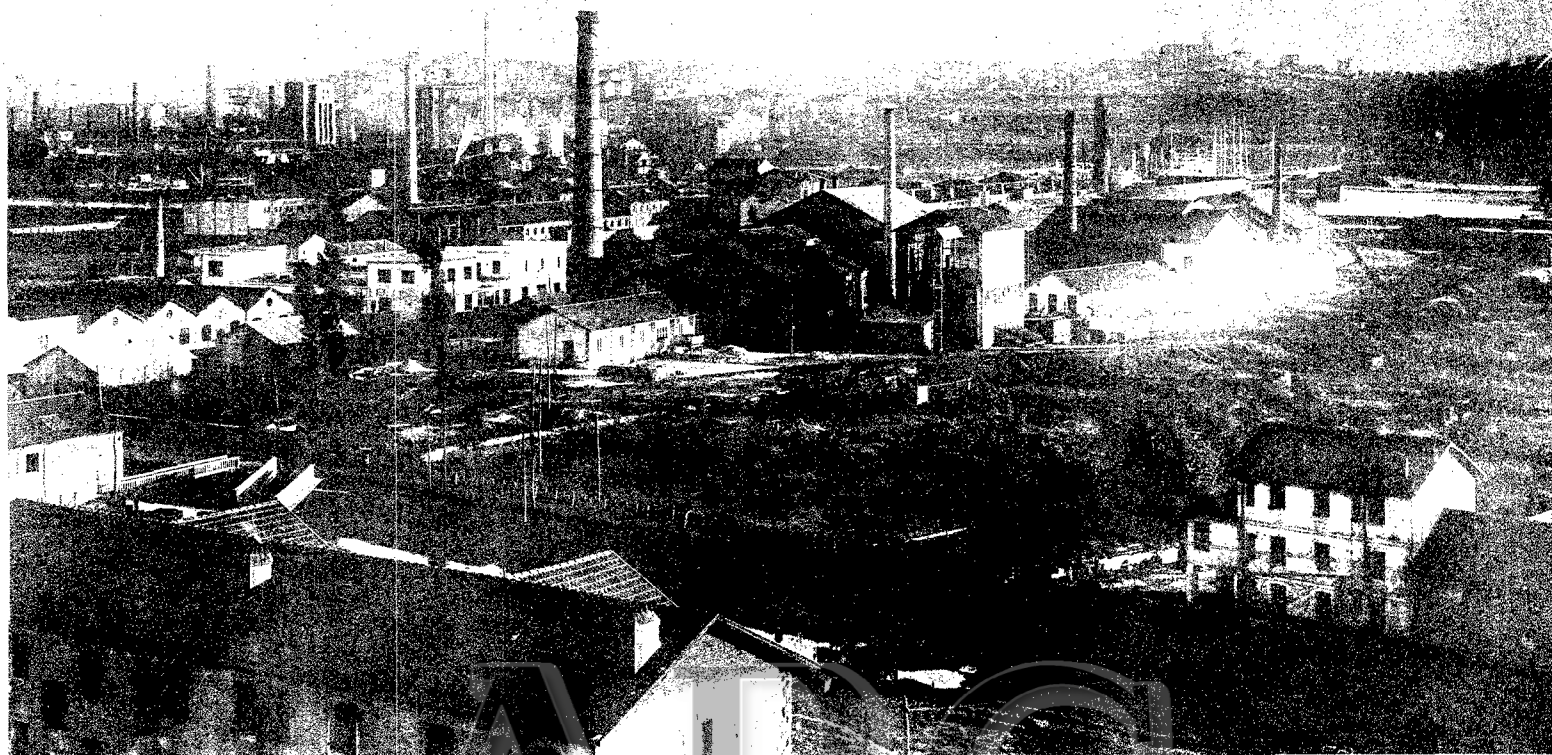
Vista de conjunto de la Fábrica de vidrio plano de Lamiaco (Lejona), de la Compañía General de Vidrieras Españolas, S. A., de Bilbao.
